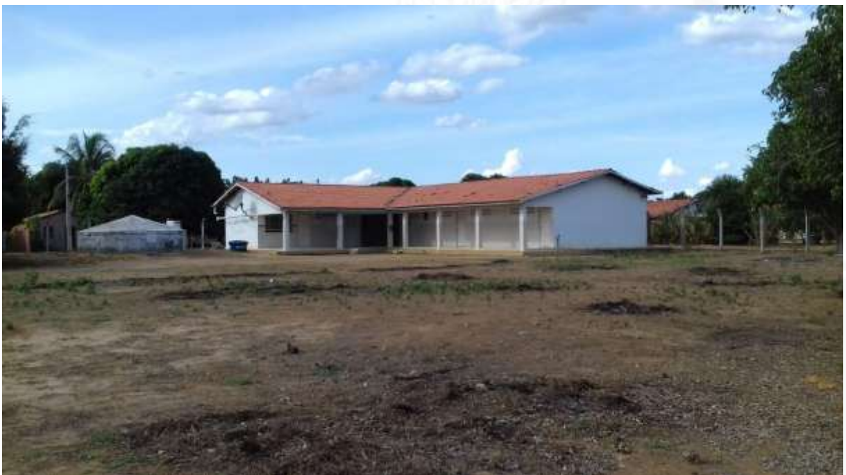
Vista do terreno
