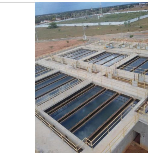
Figura 11 – Unidades de Decantação da ETA do Algodão
