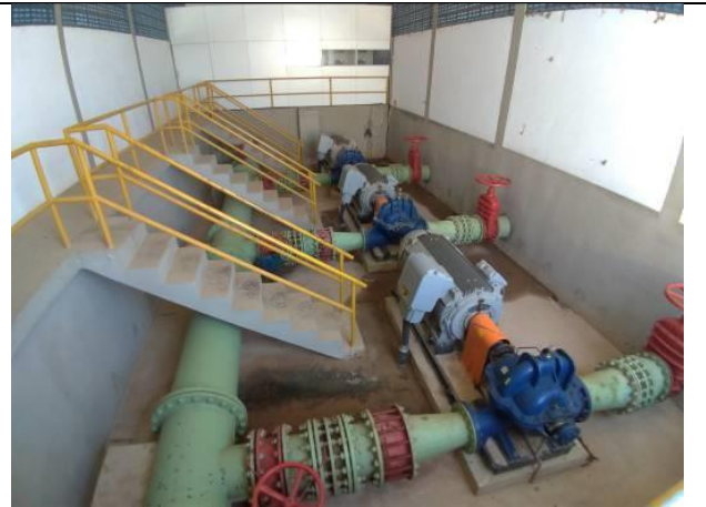
Figura 24 – Conjuntos moto-bombas da Estação Elevatória de Água Tratada 3 do Sistema do Algodão
