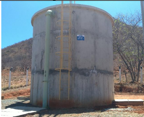
Figura 25 – Reservatório apoiado de distribuição do sistema de abastecimento de água de Matina
