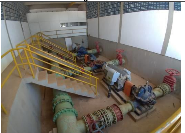
Figura 24 – Conjuntos moto-bombas da Estação Elevatória de Água Tratada 3 do Sistema do Algodão
