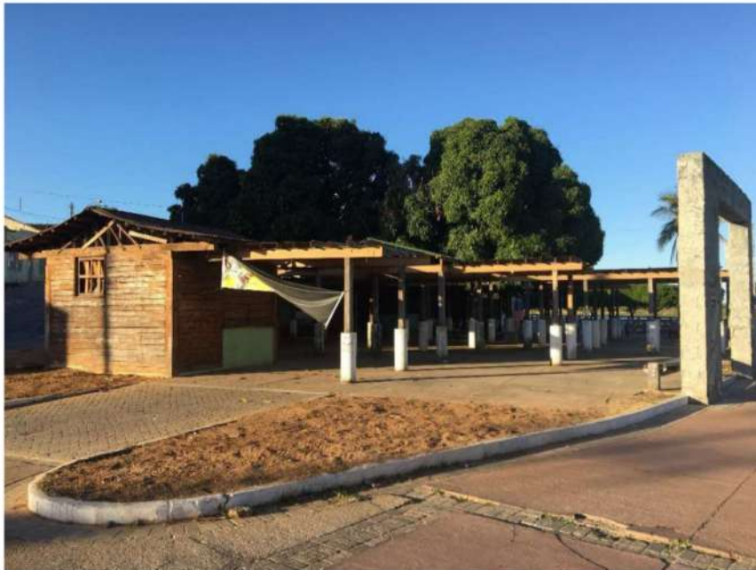
Figura 4 - Cobertura dos Quiosques e Pergolados Fonte: Prefeitura Carinhanha
