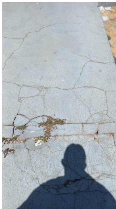
Imagem 02 – Rampa de acesso principal danificada e sem direcionamento tátil.
