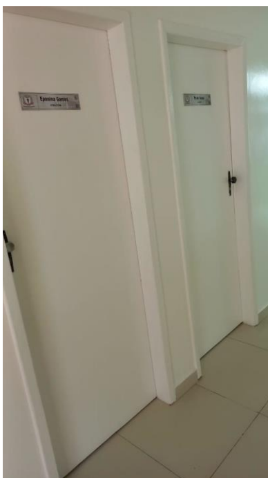
Imagem 12 – Portas sem identificação em braile.
