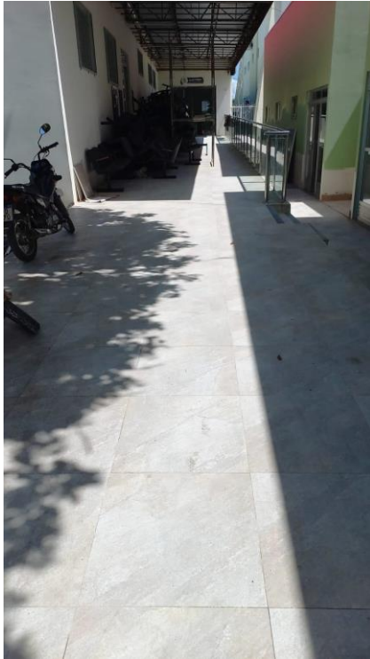
Imagem 07 – Rampa de acesso ao auditório.
