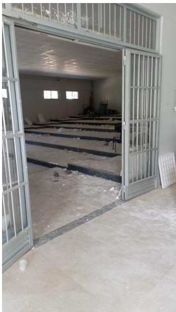
Imagem 10 – Porta de entrada do auditório.
