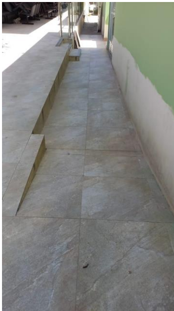
Imagem 06 – Acesso a rampa do auditório.
