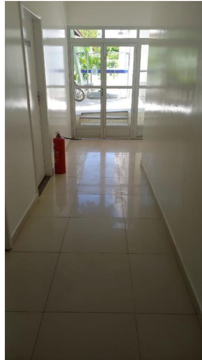
Imagem 05 – Corredor de acesso aos gabinetes com porta de saída para a rampa.
